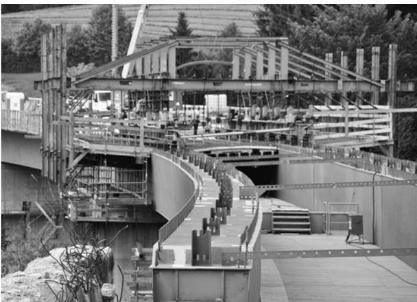
Bild 13: Betonieren der Fahrbahnplatte
