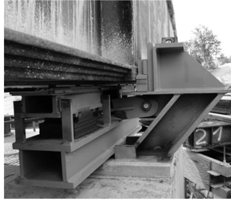
Bild 8: Ansicht Vershubkonstruktion auf den Pfeilern
