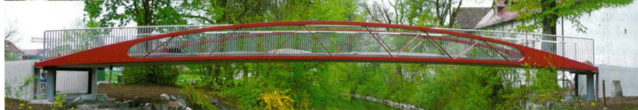
▲ Fertiges Bauwerk in Normallage um 1,15 m hochgefahren
