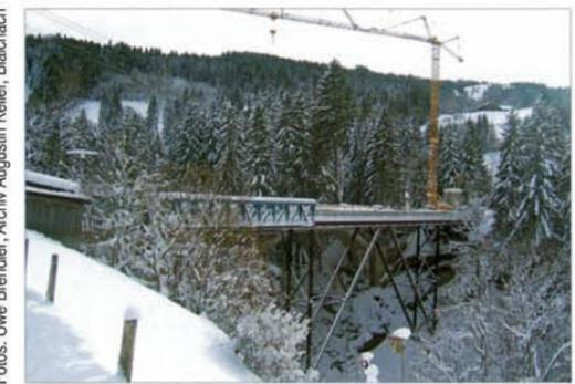
Ein Baudenkmal wird ersetzt – aktuelle Aufnahmen von der Baustelle hoch über dem Aubach. Ganz links der alte Betonbogen nach dem Abbruch der vormaligen Fahrbahn und Pfeiler, oben die neue Stahlverbundbrücke im Januar 2011, gesehen von der Behelfsbrücke, die links vor dem alten Brückenbogen zu sehen ist
