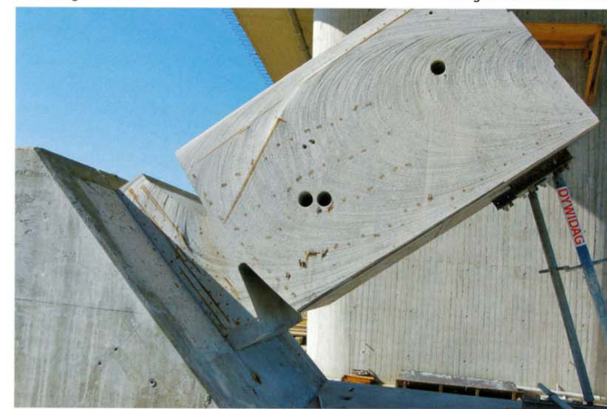
▼ Bewehrung Stumpfpfeiler und Betongelenk
