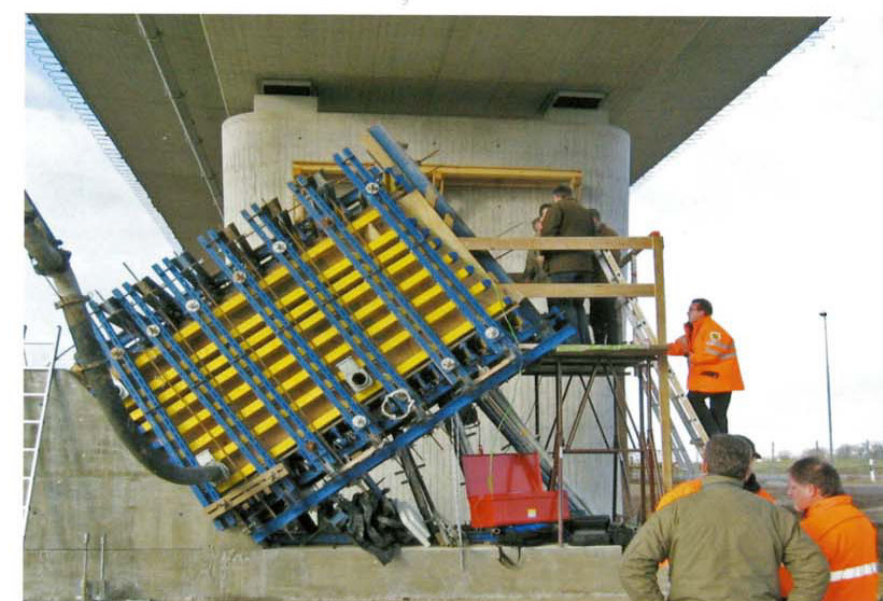
▲ Betonage Probestück
