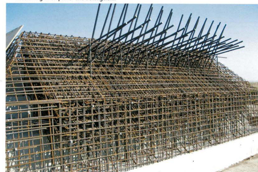
▼ Bewehrung Stumpfpfeiler und Betongelenk
