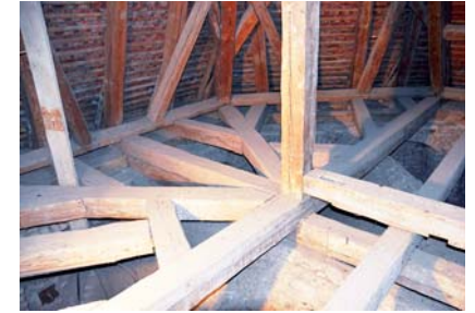
Aktivierung Hängesäule u. Rückhängung
