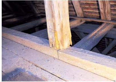
Stützenfußsanierung
