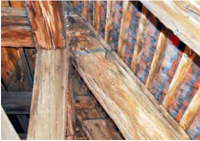
Überarbeitung Kehlbalkenanschlüsse
