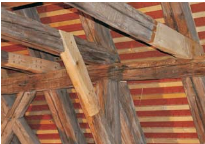
Zustand nach Instandsetzung
