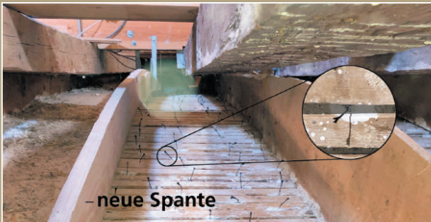
Verringerung der Lattenabstände durch zusätzliche Spante, Sicherung des Grundputzes durch Kohlefaserdübel (7)
