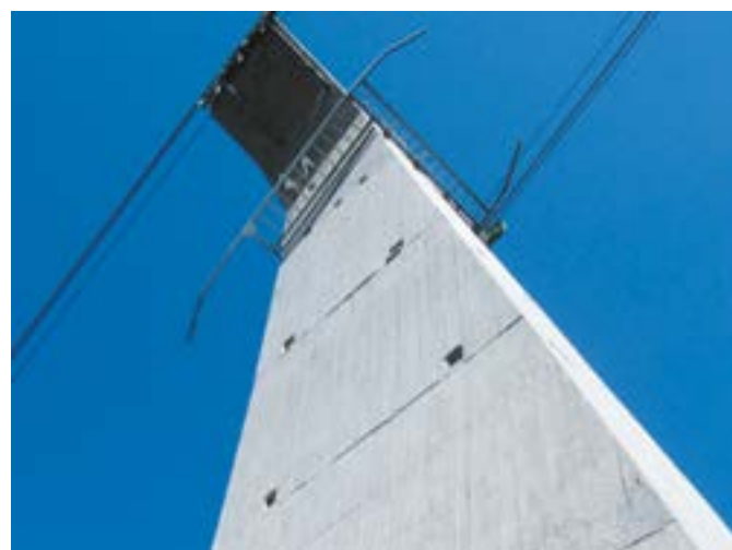
Sanierte Stützenoberfläche mit bauzeitlicher Schalbrettstruktur
