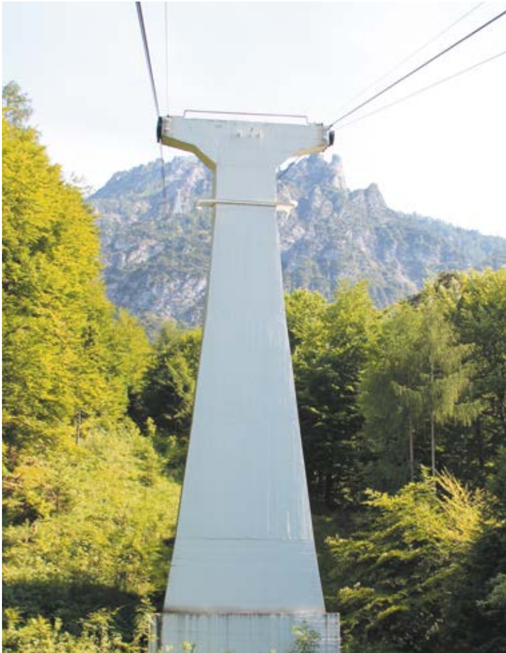
Stütze 1 vor Sanierung mit farbig beschichteter Oberfläche
