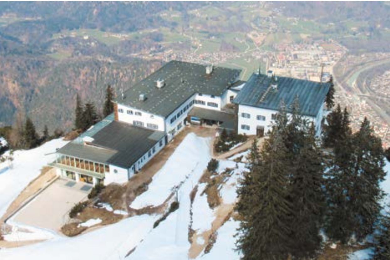
Bergstation Innenhof nach durchgeführter Sanierung
