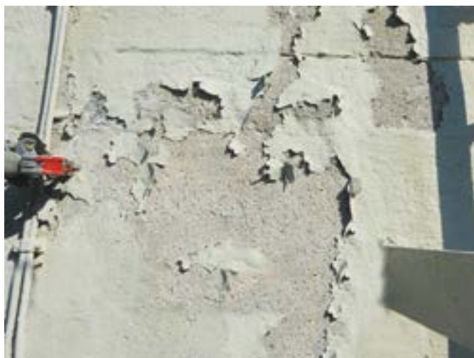
Ablösende Bestandsbeschichtung
