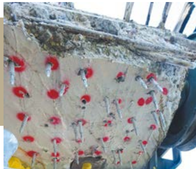
Sanierungsarbeiten an der geschädigten Stützenkopfunterseite
