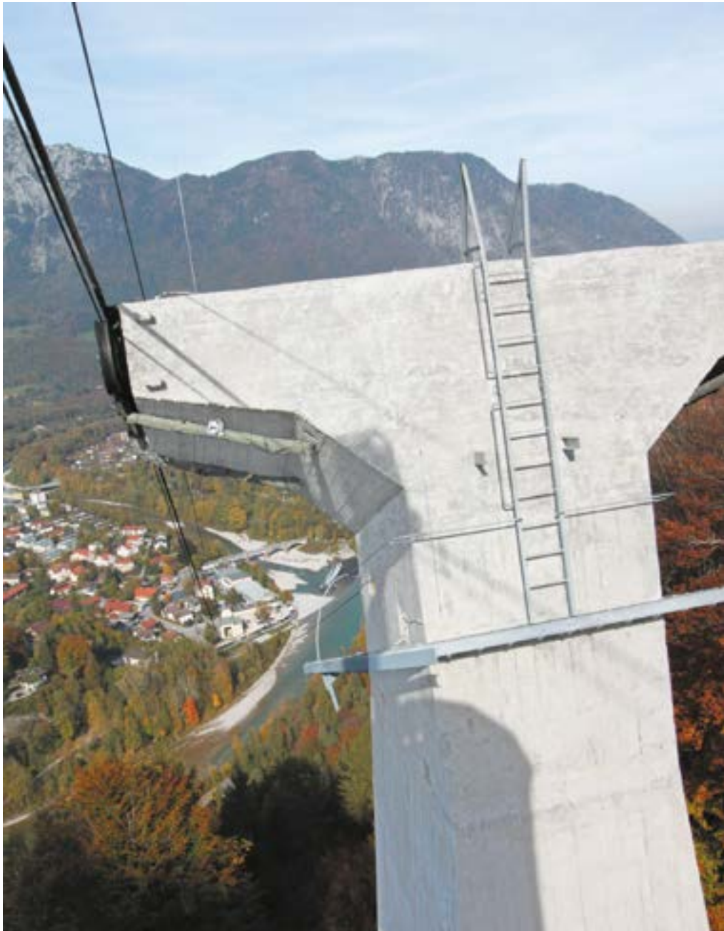
Sanierter Stützenkopf
