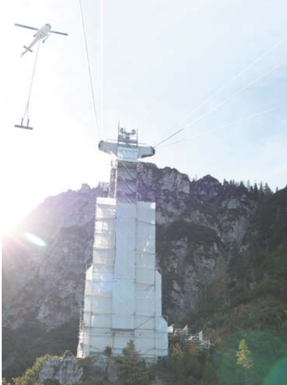
Materialtransport mittels Helikopter
