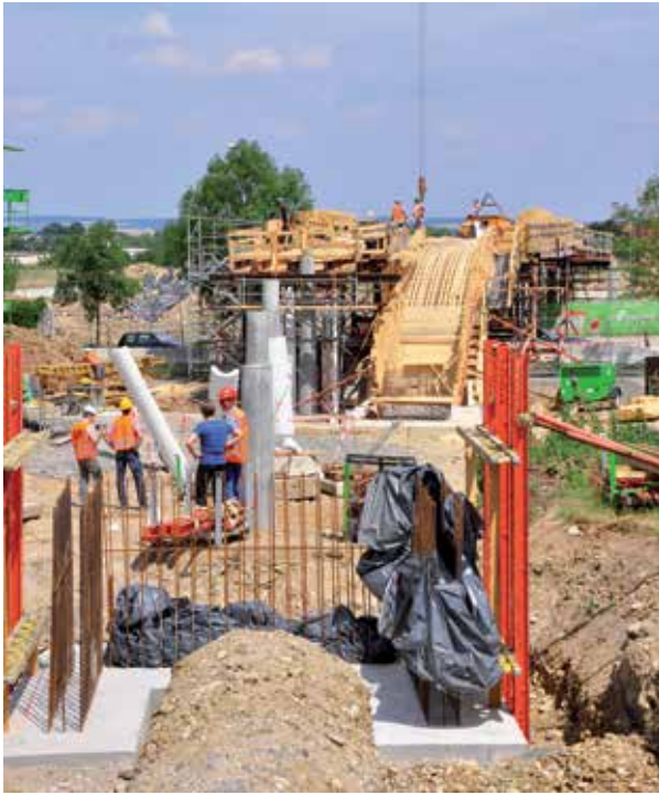
21 (Aktueller) Bauzustand im Sommer 2013 © Dr. Schütz Ingenieure
