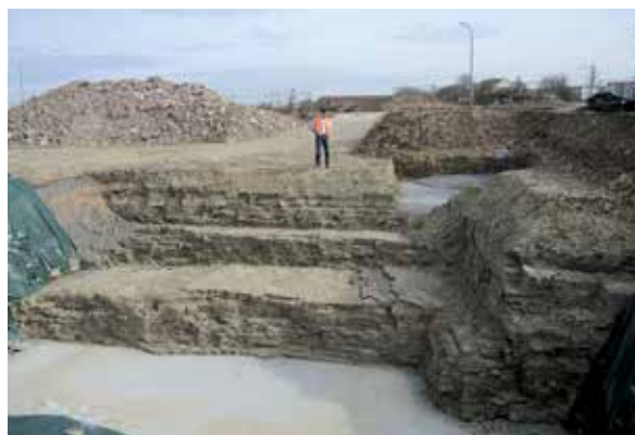
20 Baugrube am nördlichen Widerlager © Dr. Schütz Ingenieure
