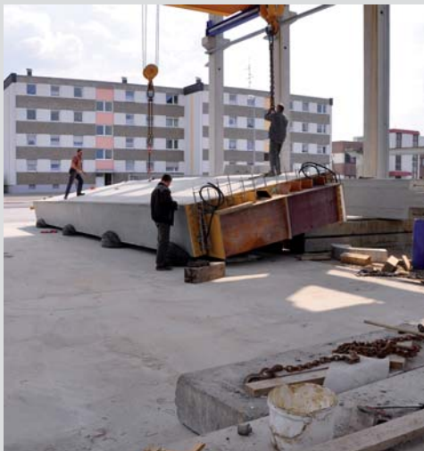
Drehen des Fertigteils 1 im Werk
