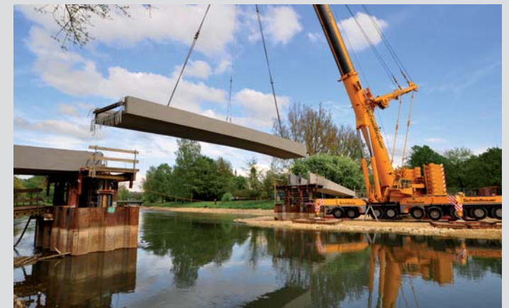
Einhub Fertigteil 2, 95 t
