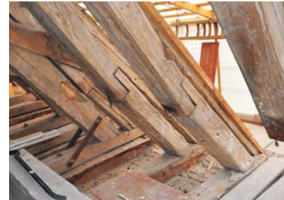
Instandsetzung Dachfußpunkt
