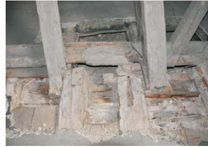
Dachfußinstandsetzung im Mittelbau
