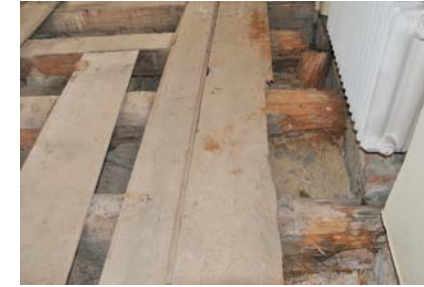
Instandsetzung von Deckenbalkenköpfen
