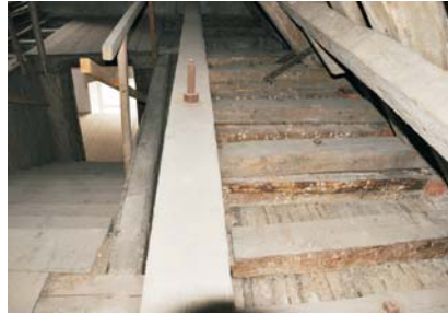
Verstärkung der Treppenauswechslung
