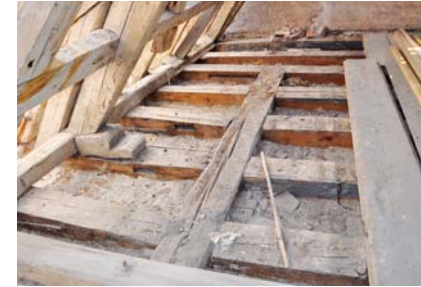
Instandsetzung Dachfußpunkt
