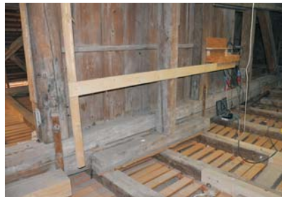
Zustand nach Instandsetzung
