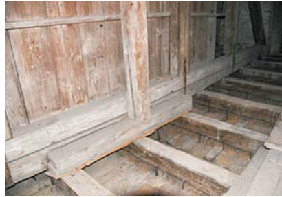
Hängewerk Verstärkung
