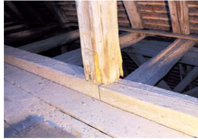
Stützenfußsanierung
