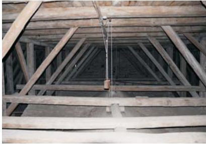
Subsidärtragwerk Langhaus
