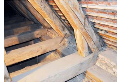
Fußpunktinstandsetzung Langhaus
