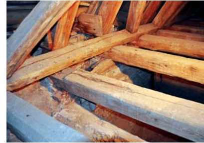
Fusspunktinstandsetzung
