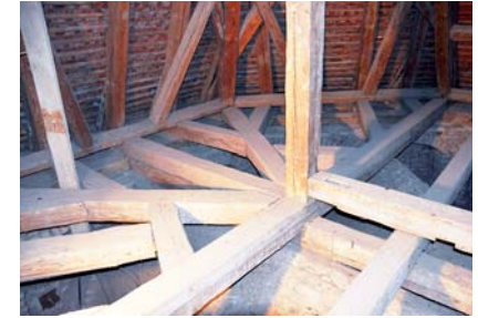
Aktivierung Hängesäule u. Rückhängung
